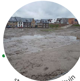
start aanleg speeltuin
